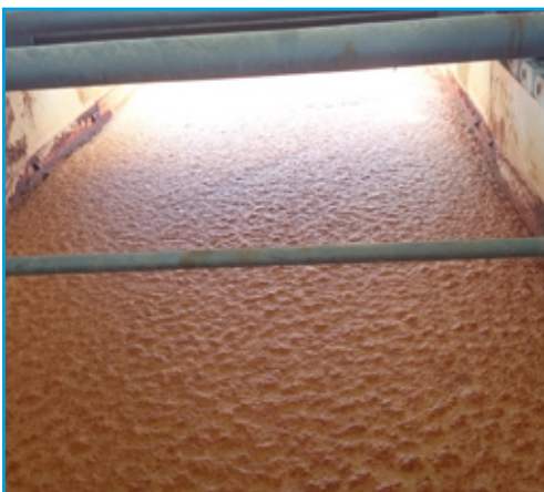
使用MicroGas™改装的DAF系统
